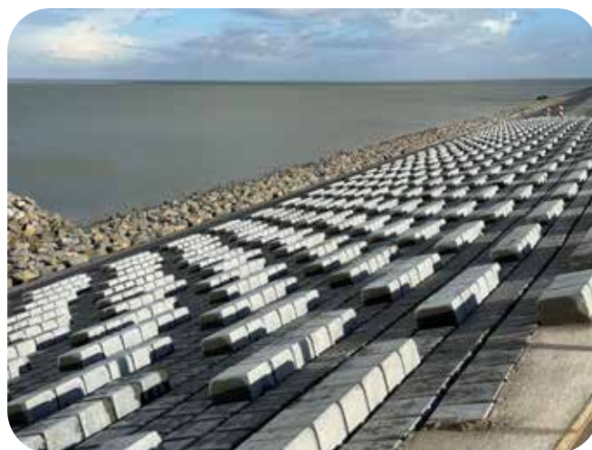
Verkalit®-steen en Verkalit®-golfoplopende remmende stenen dijk Lauwersoog
