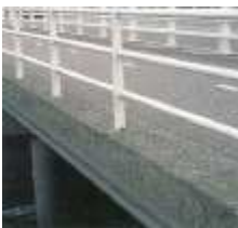
Betonnen rand bij een viaduct ...
