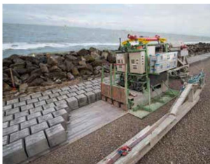
Verkalit® met gegroefde hol en dol verbinding.
